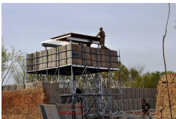
A figyelő építése 68
