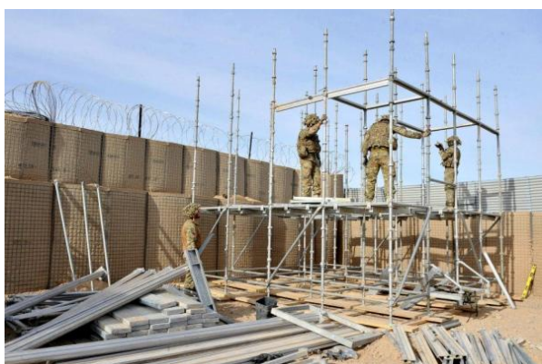
Az állványzat építése 67
