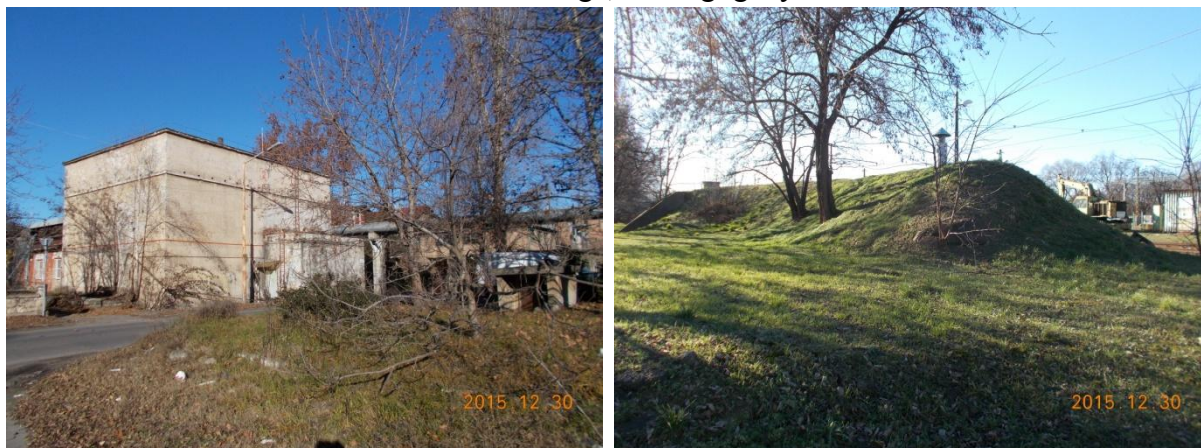
5-6. kép: Az 5. (baloldali) képen talajszint feletti különálló BGS óvóhely egy gyártelepen, a 6. (jobboldali) képen, telephelyen rézsú alatti vasbeton csőelemekből épített különálló Rocla óvóhely látható. 8
