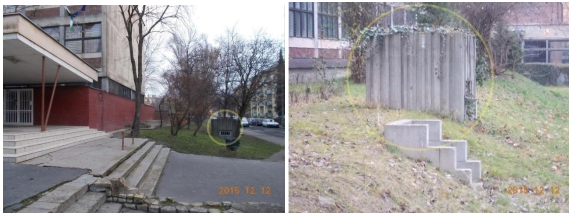
9-10. kép: A 9. (baloldali) képen egy kerületi vezetési pont üzemanyag-tároló helyiségének külső csatlakozása, a 10. (jobboldali) képen a létesítmény romhatáron kívül vészkijárata látható. 14
