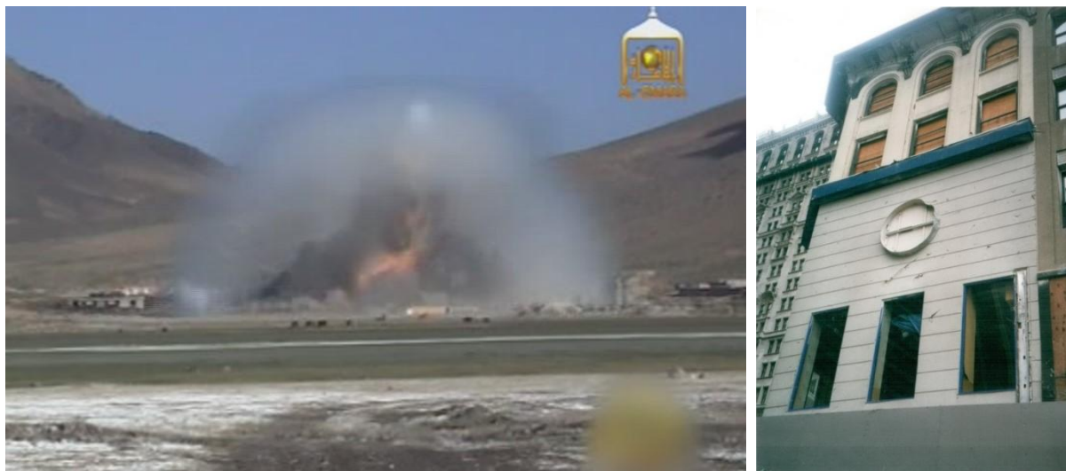
1-2. kép: Az 1. (baloldali) képen léglökés hullám, a 2. (jobboldali) képen törmelékhatás és szilánkhatás nyoma a WTC 4 közelében megmaradt épülethomlokzaton 2002.-ben 5
