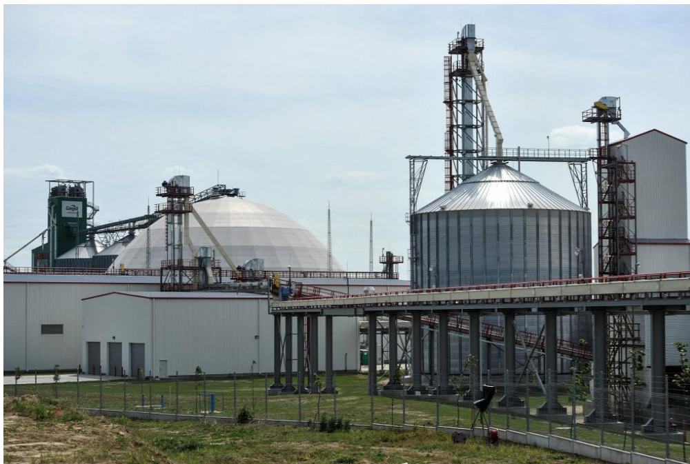
6. sz. ábra. A Pannónia Ethanol kerítése és zöld területe. [22 p.1.]
