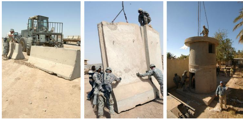
27. ábra: mobil vasbeton falak és kiegészítőinek (őrtorony) telepítése 36
