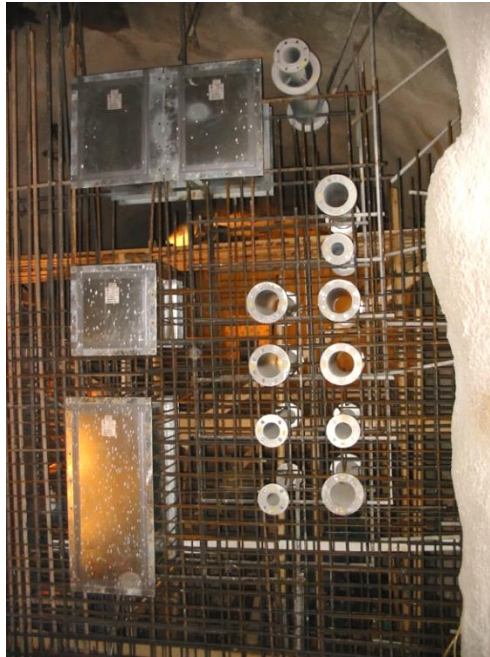
1. ábra: Óvóhelyi szerelvények elhelyezése a vasbeton védőfalban betonozás előtt 2
