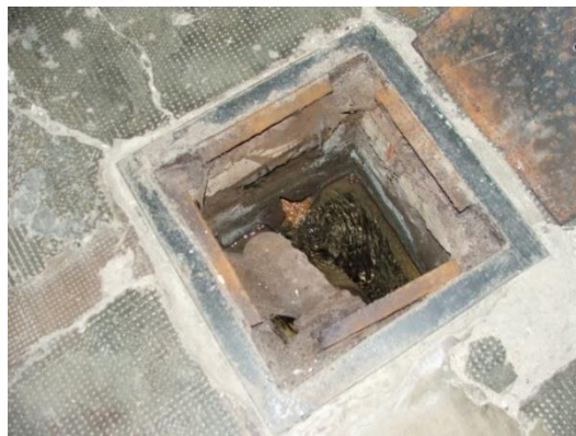
31. ábra: Drénrendszer gázzáróságát biztosító zsomp az egyik gázzáró ajtó előtt KAGRA létesítményben 34
