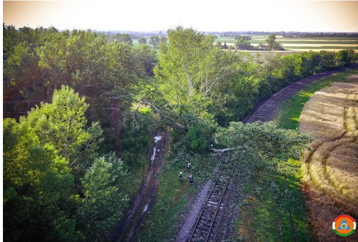
7. kép: Vasúthálózat felderítése UAV-val 16
