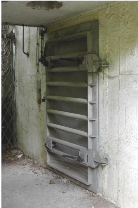
9. ábra: Volt G-1 (Diósgyőri Gépgyár (DIGÉP)) óvóhely egyik bejárata Mexikóvölgyben 16
