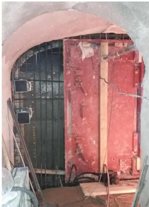
8. ábra: Új, nagy védőképességű védőajtó beépítése a budai Várban 15
