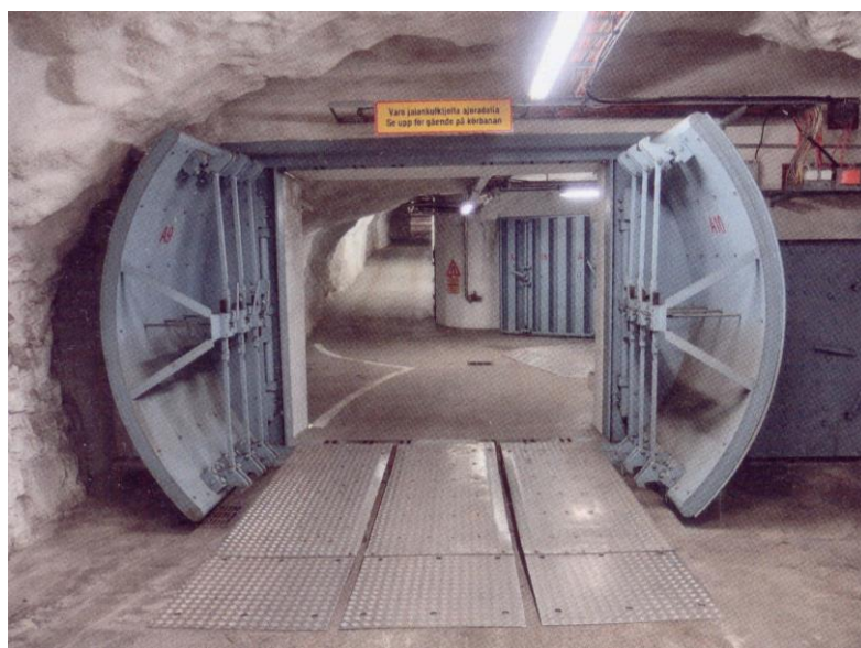
19. ábra: Marienthali kormányóvóhely a volt NSZK-ban kézi forgó zárócsappal 26
