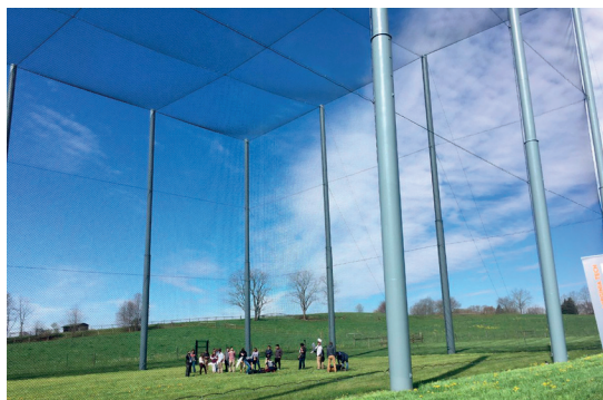
9. ábra: PearlWeave típusú kifeszített UAV-védőháló
