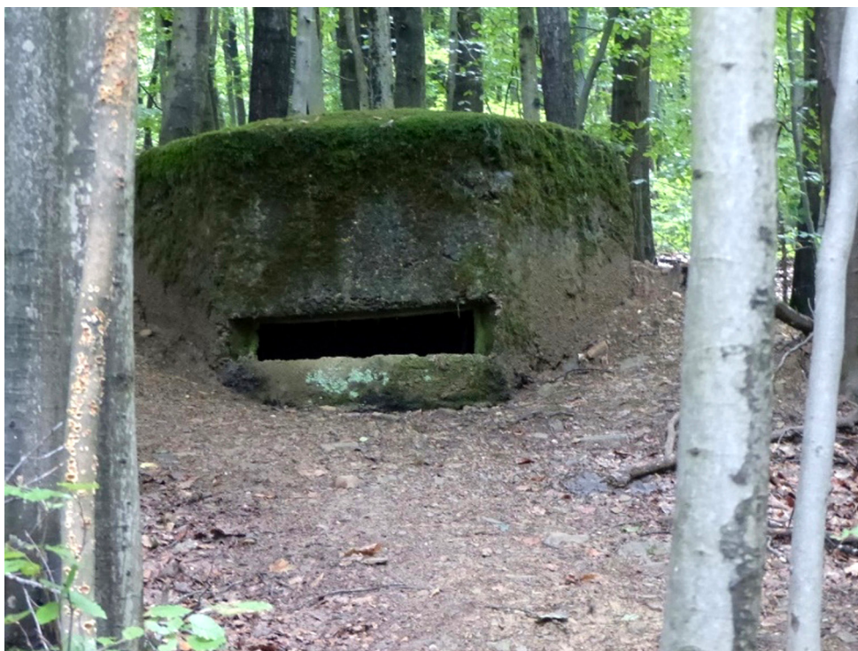
6. ábra: Vasbeton géppuskaállás, Utcás
