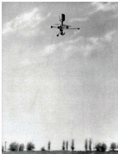
4. ábra: A megfigyelőkosaras PKZ-2 kötött helikopter 50 méter magasságban repül 1918 tavaszán Pestszentlőrincen, a Lipták-gyár mellett
