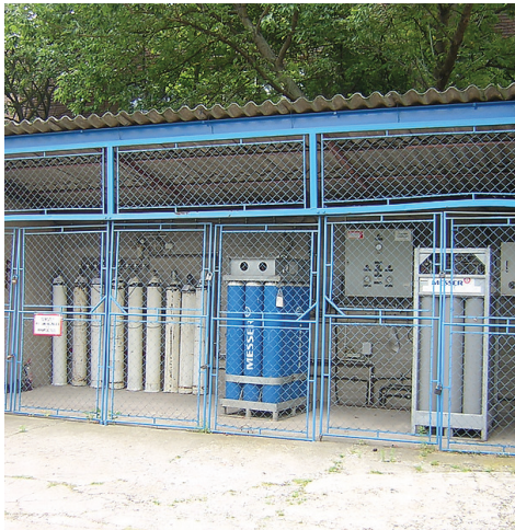
8. ábra: Példa egy kórházi telephelyen, kis palackok központi tárolására
