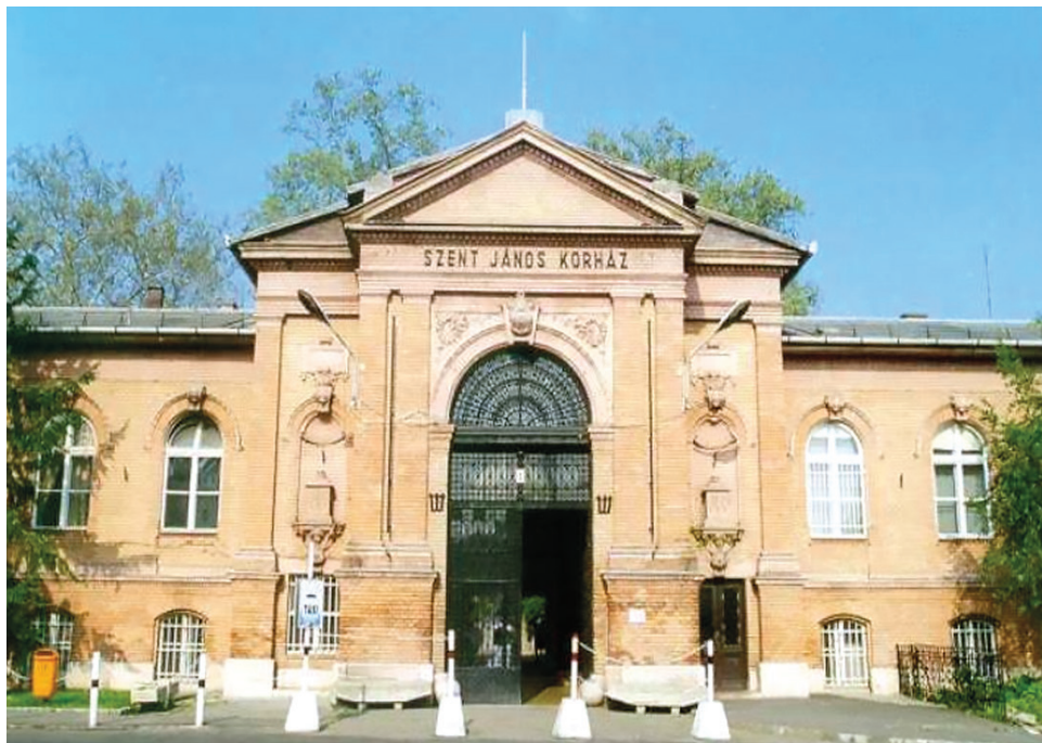
1. ábra: Kórházi fogadó épület, személybejárati kapuk (Napközben folyamatosan nyitott állapotban vannak, és mögötte van portásfülke, így a portás részben tudja felügyelni a forgalmat.)
