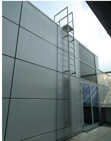
7. ábra: Külföldi példa egy tetőfeljáró létra lezárására, kulccsal nyitható kivitelben
