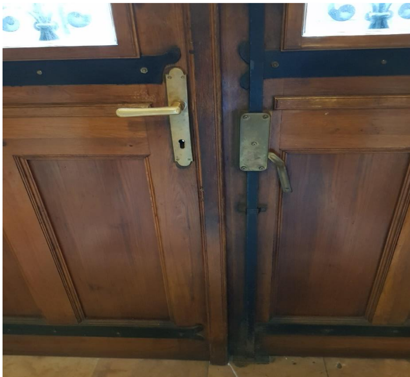
3. ábra Vaspántokkal megerősített bejárati ajtó (Forrás: Saját készítésű ábra)
