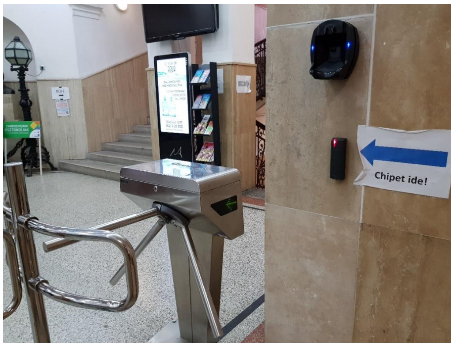
4. ábra Az Óbudai Egyetem lengővillás birtok alapú beléptető rendszere
