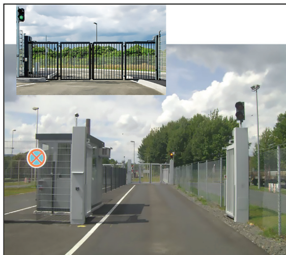
3. ábra: Automata zsiliprendszer járműforgalom számára
