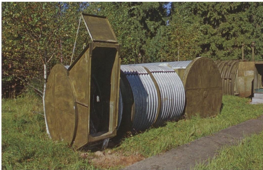
2. фото Сооружение из элементов волнистой стали КВС-А 2
