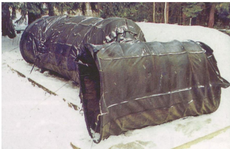
3. фото Сооружение каркасно-тканевой конструкции ЛКСЗ 3
