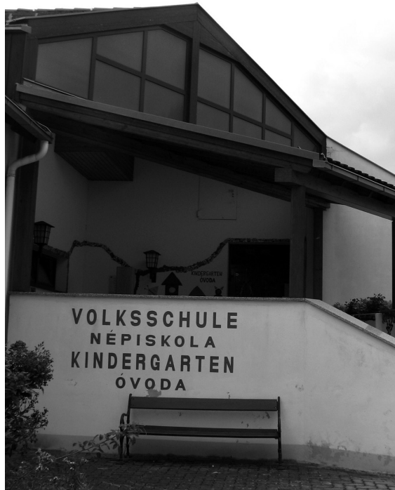
6. kép: Az alsóöri általános iskola bejárata
